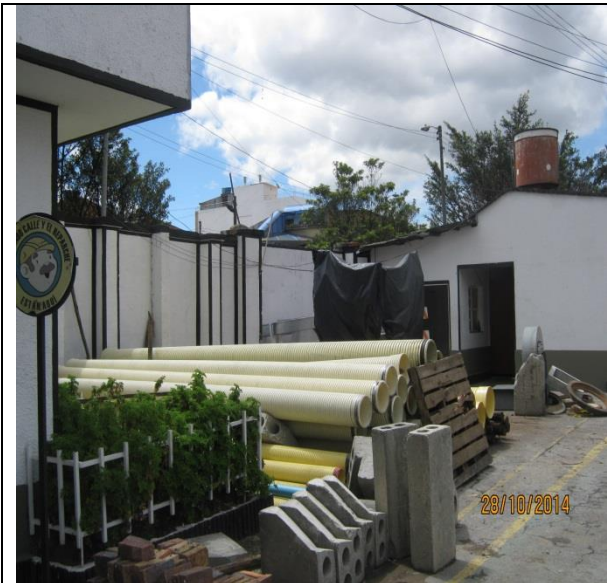
Foto 7. Panorámica de la zona de patio de la UAERMV. En este sitio se almacena tuberías hidrosanitarias.
